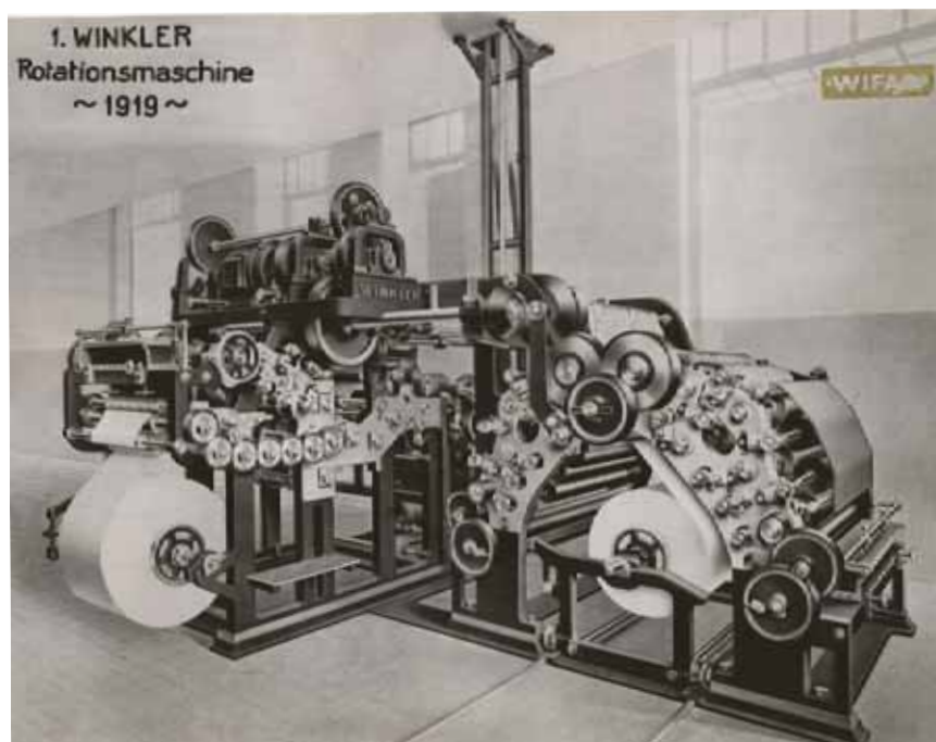
Bild 5: Die erste WIFAG-Rotationsdruckmaschine in winkliger, platzsparender Anordnung.
